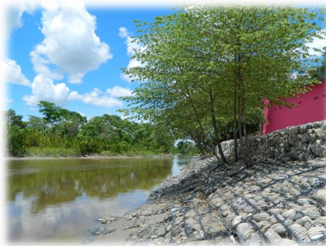
Imagen 3 Gaviones del margen izquierdo del Rio Ariari junto al Malecón
